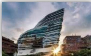
香港理工大学创新楼 2009 Innovation Tower, HK
