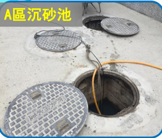
ABC區基地內明溝雨水沉砂後 流入筏基層雨水滯留池
