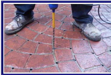
嚴重阻塞可搭配高壓水柱及鑽孔設施清理導水孔
