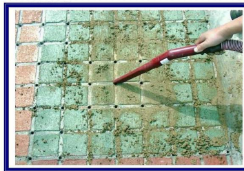
中度阻塞時可以吸塵器及掃街車清理維護
