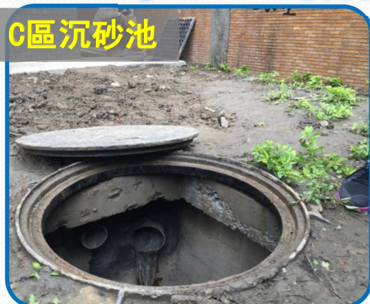
ABC區基地內明溝雨水沉砂後 流入筏基層雨水滯留池
