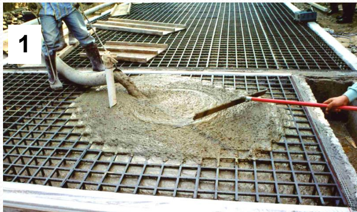
倒入混凝土
