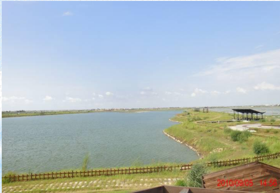
龙宫溪排水系统-新塭滞洪池
