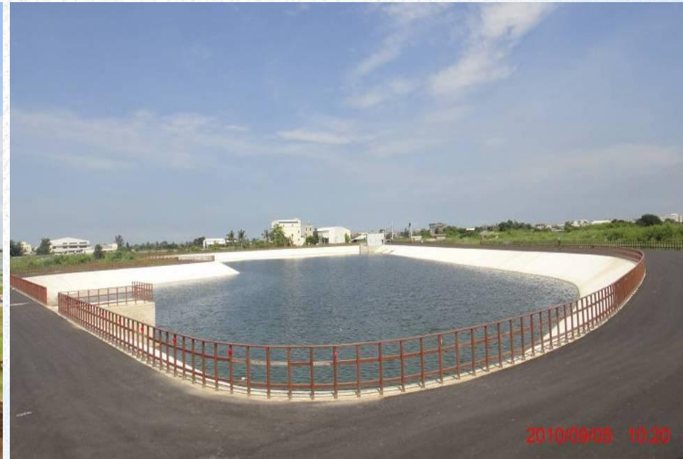
龙宫溪排水系统-后镇村落滞洪池
