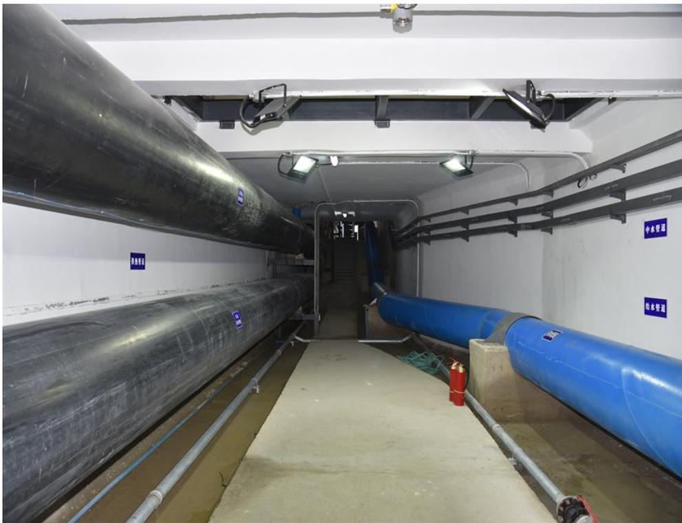
**供水、中水管线**入廊是容易解决的，可与各种管线同仓，供水管线是有压管线，管线转角、转弯要求相对较少。一般选用钢管，中水管线和供水管线一样。
