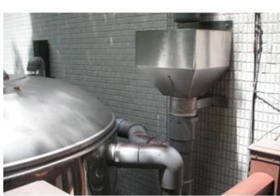
雨水進儲槽前濾網、初期雨水處理裝置與溢流管(萬芳高中信義樓)
