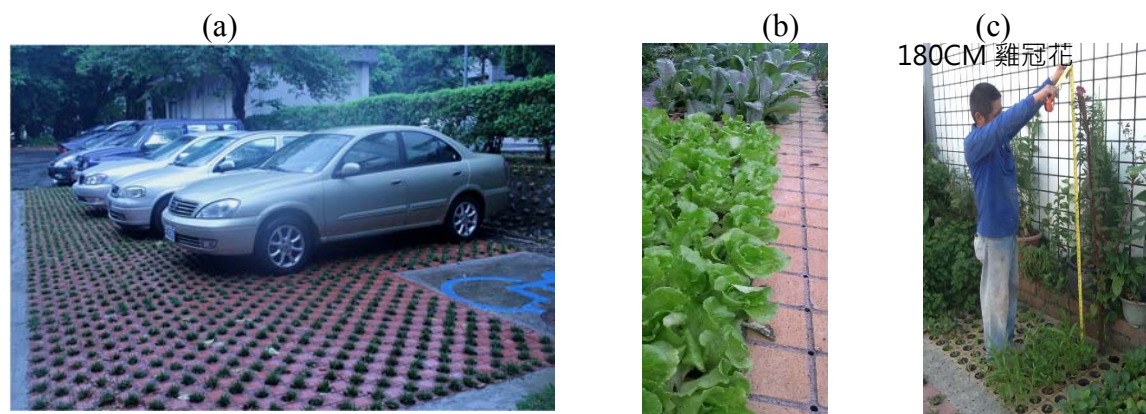
圖 8：(a) JW 生態工法植草鋪面停車場 (b) JW 鋪面蔬菜植栽區 (c)在 JW 鋪面上種植雞冠花持續生長超過 180cm
