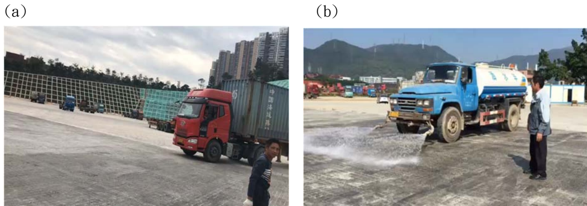
圖 10 JW 生態工法施作於深圳市鹽田港貨櫃車進出口高承載高透水道路
