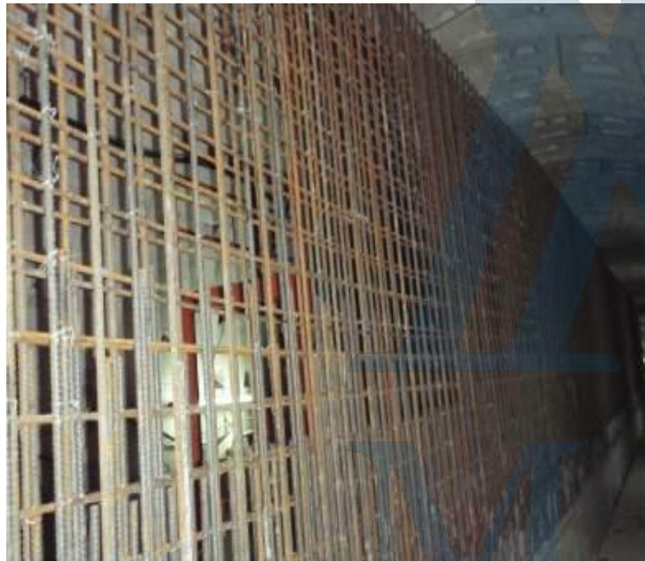
共同管道盾构隧道中隔墙钢筋绑扎
