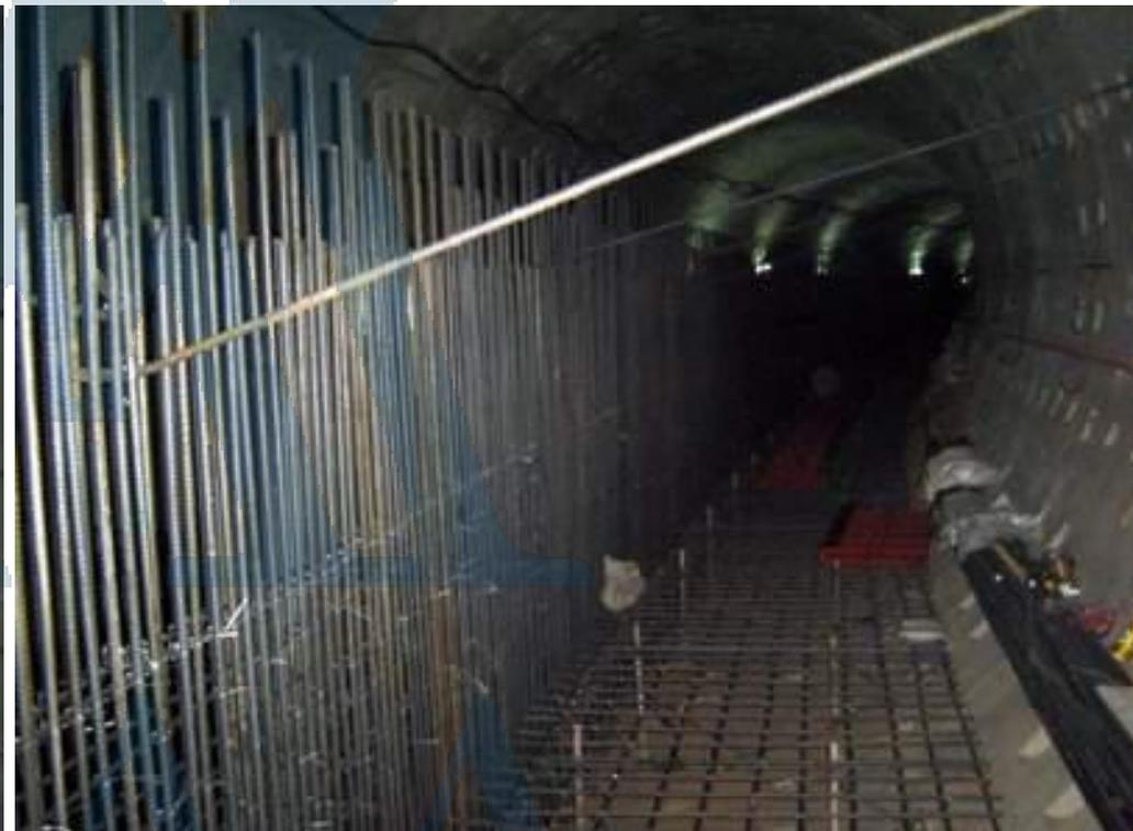
共同管道盾构隧道仰拱中隔墙钢筋绑扎
