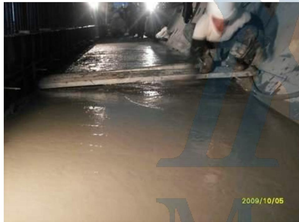
共同管道盾构隧道仰拱浇筑置整平
