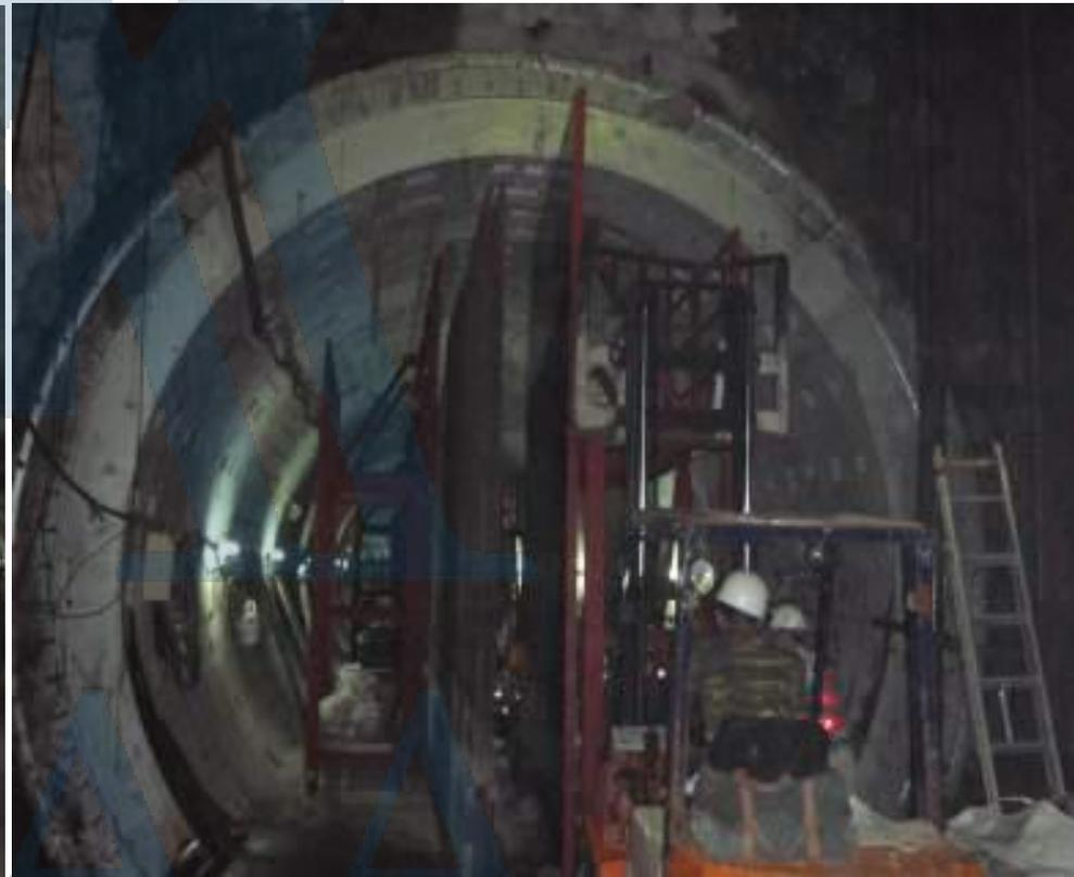
共同管道盾构隧道中隔墙模板投入
