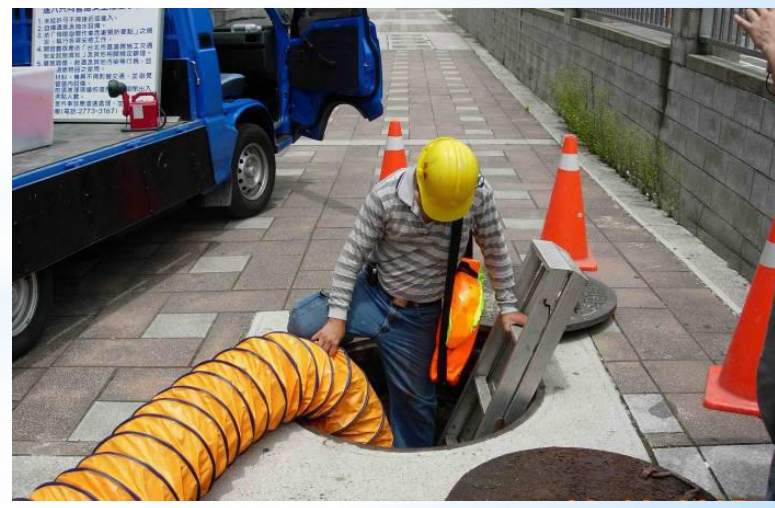
4. 人员进入管道内施工
