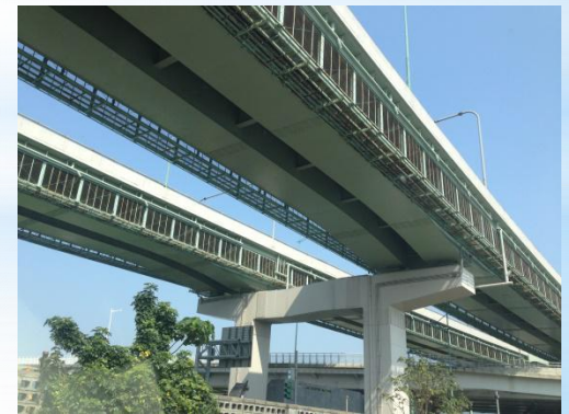
高架共同管道
