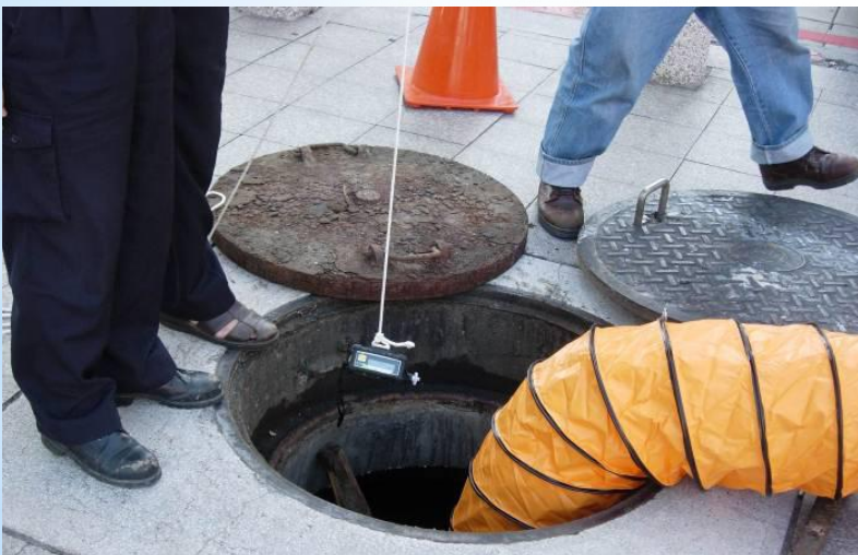
3. 使用侦测器侦测管道内气体数值
